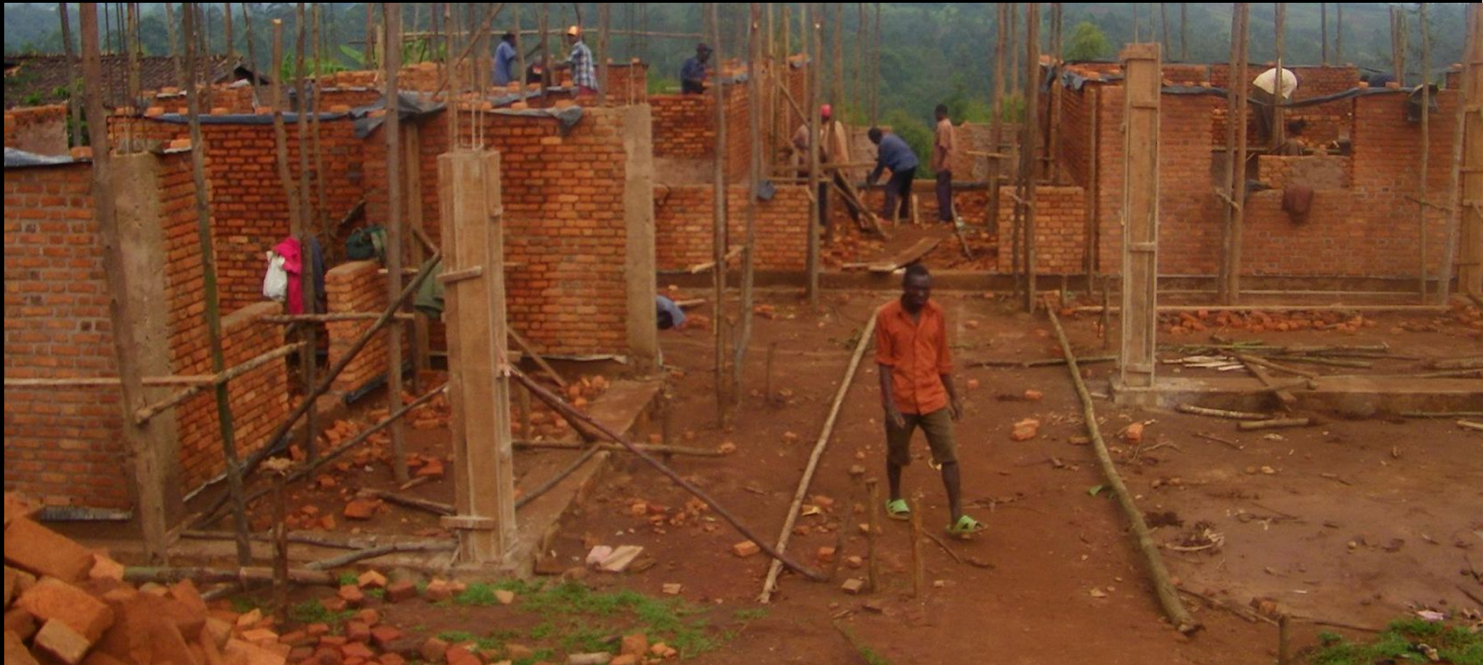
01-01 – Construction du bâtiment et ameublement Région Île-de-France 10.000 € et 10.000 € association
