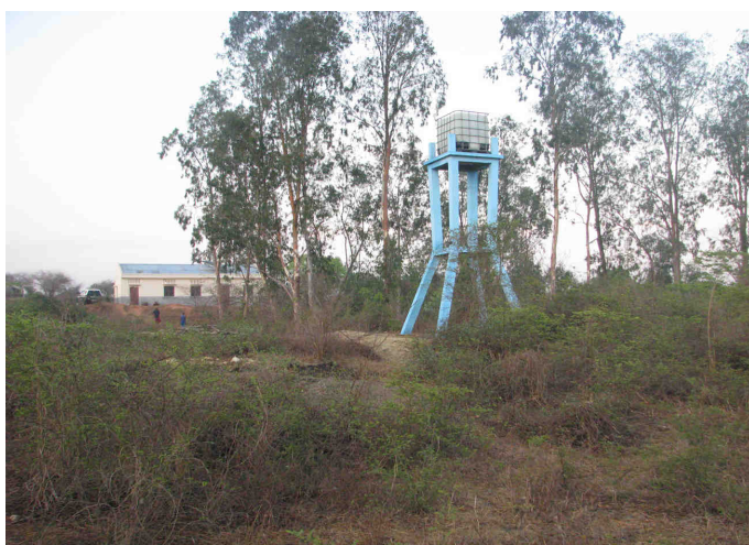
Refonte du réservoir de Manamby (Projets 2012)
